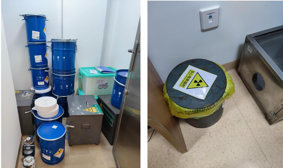
图 3-3 带屏蔽的废物桶和放射性废物暂存间的废物桶
